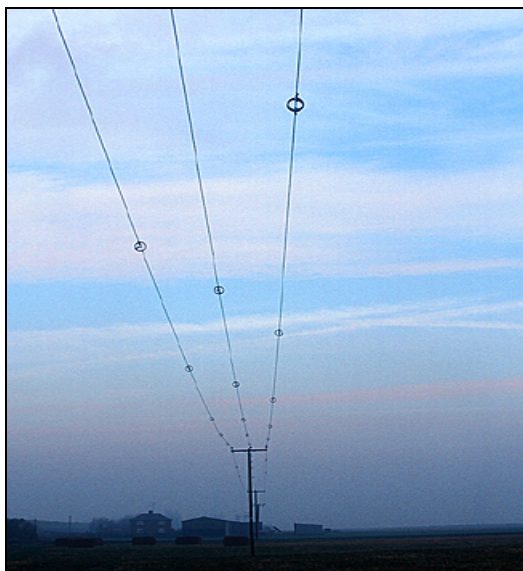
16. mynd. Áflugsvarnir á rafhlínum í Norfolk, Austur-Anglíu, Englandi. Til vinstri eru gormar á dreifilínu, til hægri eru belgir á jarðvír á stórrí háspennulínu. Ljós. JÓH 19. og 20. nóvember 1998.
