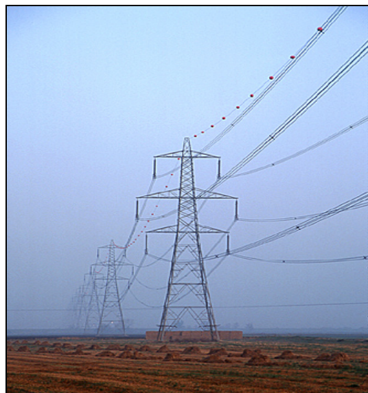
16. mynd. Áflugsvarnir á rafhlínum í Norfolk, Austur-Anglíu, Englandi. Til vinstri eru gormar á dreifilínu, til hægri eru belgir á jarðvír á stórrí háspennulínu. Ljós. JÓH 19. og 20. nóvember 1998.
